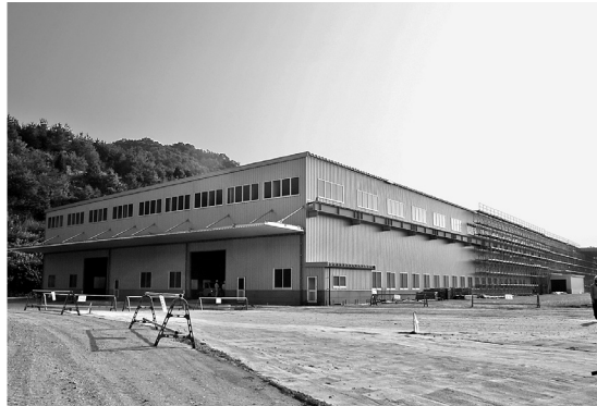
来年1月稼働予定の尾道新工場
